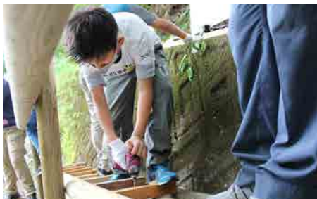
初めて電動ドリルを使う作業もコツを掴んで、傾斜のある歩道に上手に枕木を固定していました。
